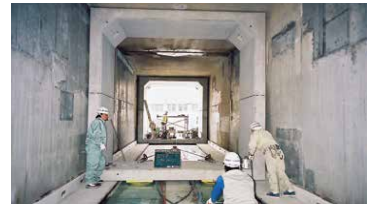
狭隘部分の施工例 [w=15.8t]
