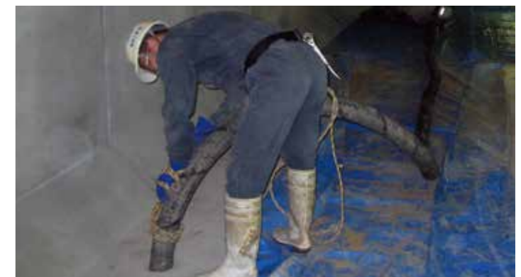
底版モルタル充填工例
