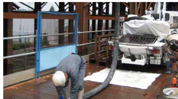
コンクリートポンプ車配管状況例
