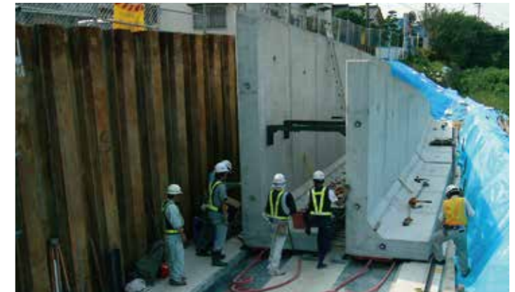
L型部材の連結施工例 [w=11.6t]
