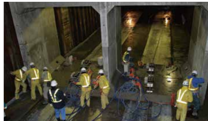
連結施工例 (2 函体連結) [w=67.4t]
