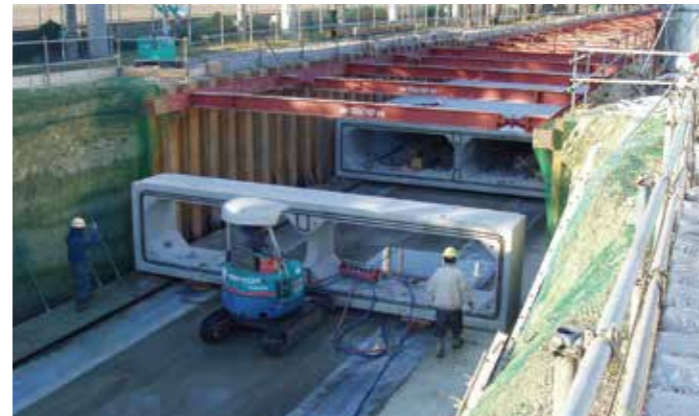
長距離施工例 (移動距離 206m) [w=12.3t]
